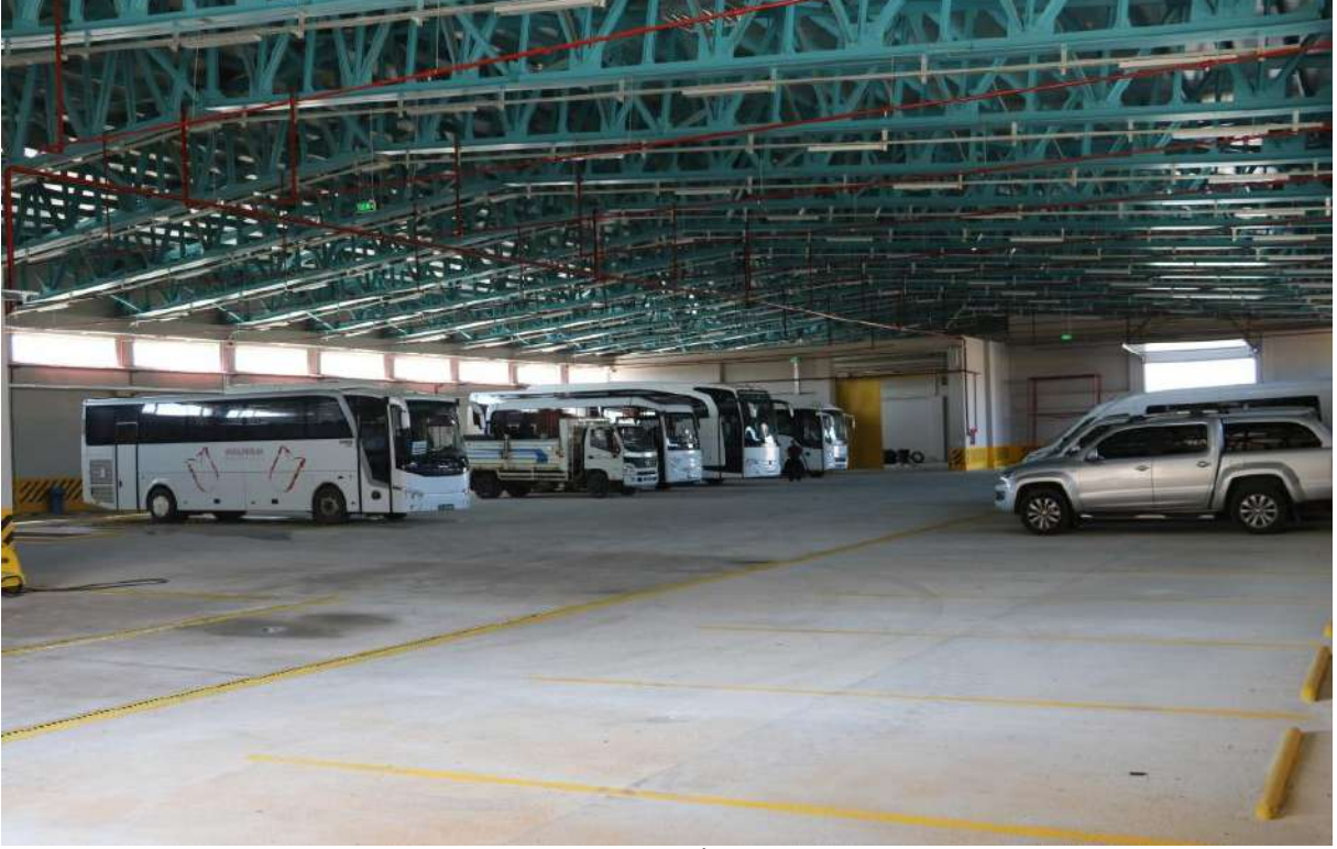
Resim 4. Hangar İç Görünüm
